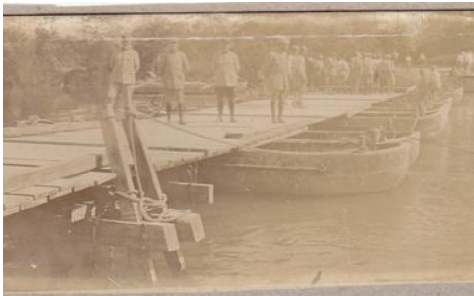
Le 3ème RG réalise un pont dans l'Aisne en 1917 Le Lieutenant Drianno à gauche.
